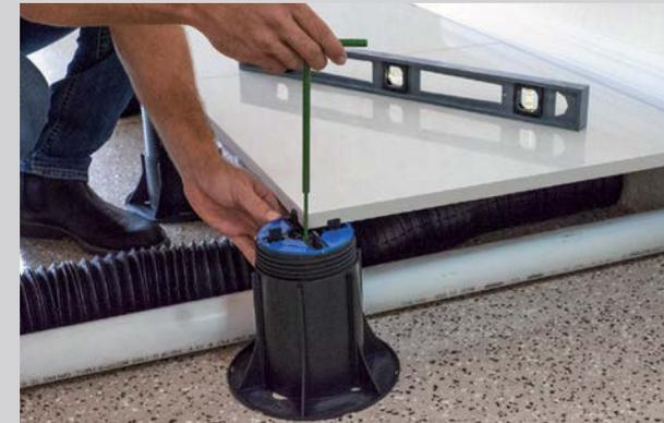
Erhältlich in fünf Größen/Höhenbereichen für 2 mm und 3 mm breite Fugen
